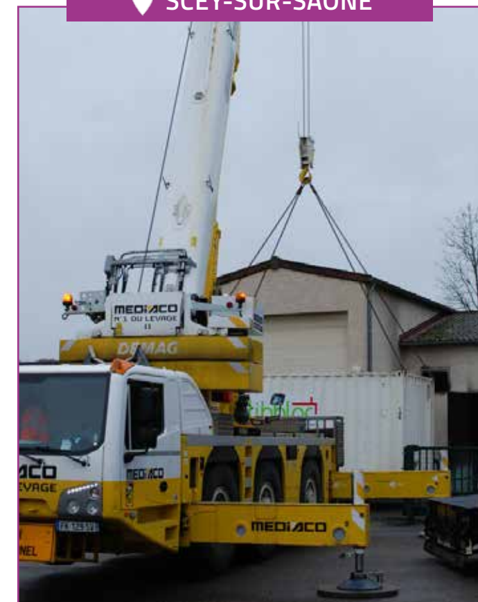
Installation d'une centrale de chaleur itinérante
