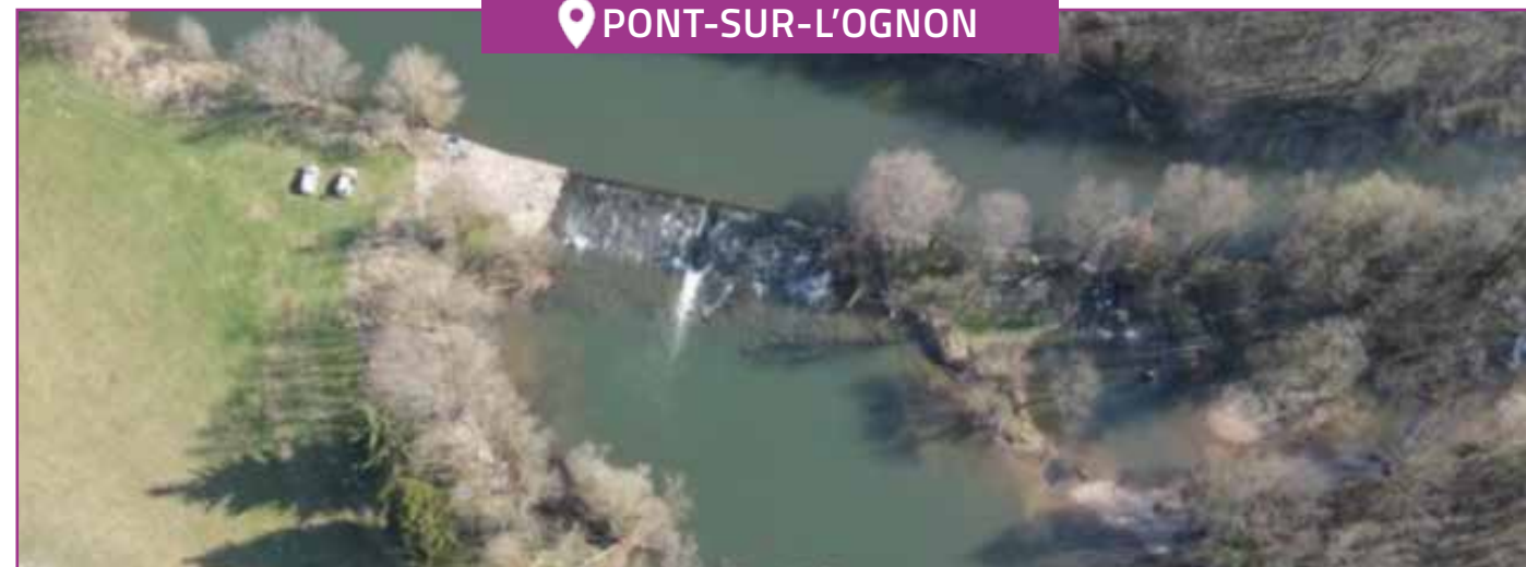
Emplacement de la future microcentrale hydroélectrique de PONT-SUR-L'OGNON
